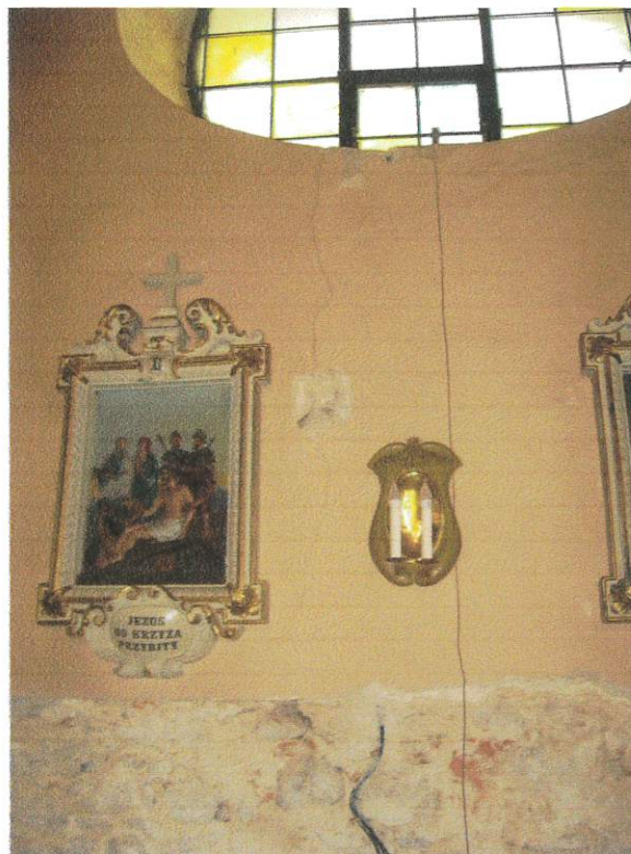
Fot. 16. Widok od wewn. pęknięcia północnego muru nawy kościoła.
