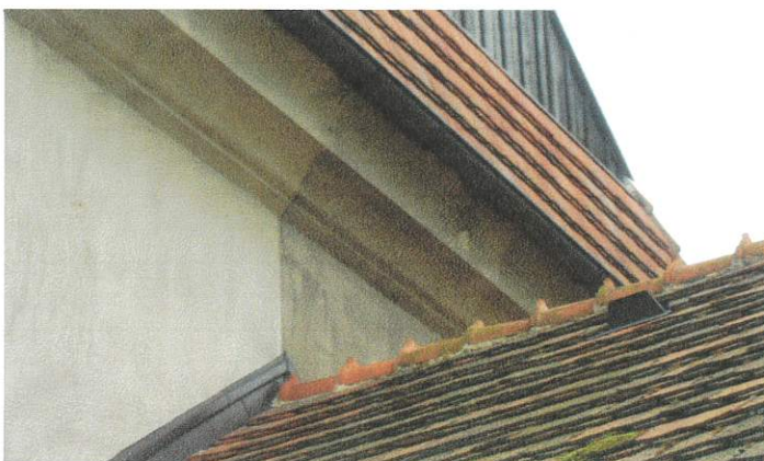
Fot. 6. Zarysowanie ściany szczytowej zachodniej nawy głównej - nad dachem kruchty ;
