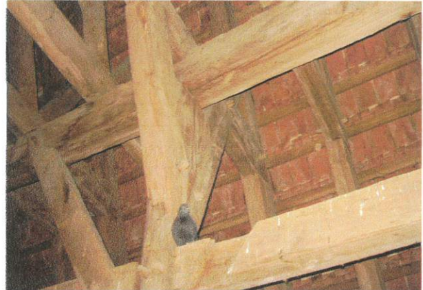
Fot. 9. Braki elementów więźby dachowej - tu brak środkowego miecza podłużnego nad nawą ;
