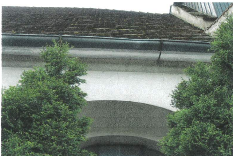
Fot. 5. Zarysowanie nad oknem w elewacji północnej oraz widok pokrycia dachowego ;
