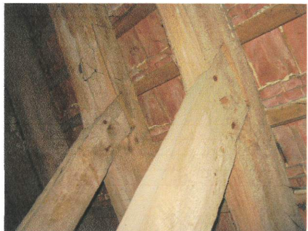
Fot. 11. Wysunięty zastrzał z węzła z krokwią - brak dybli połączeniowych ;
