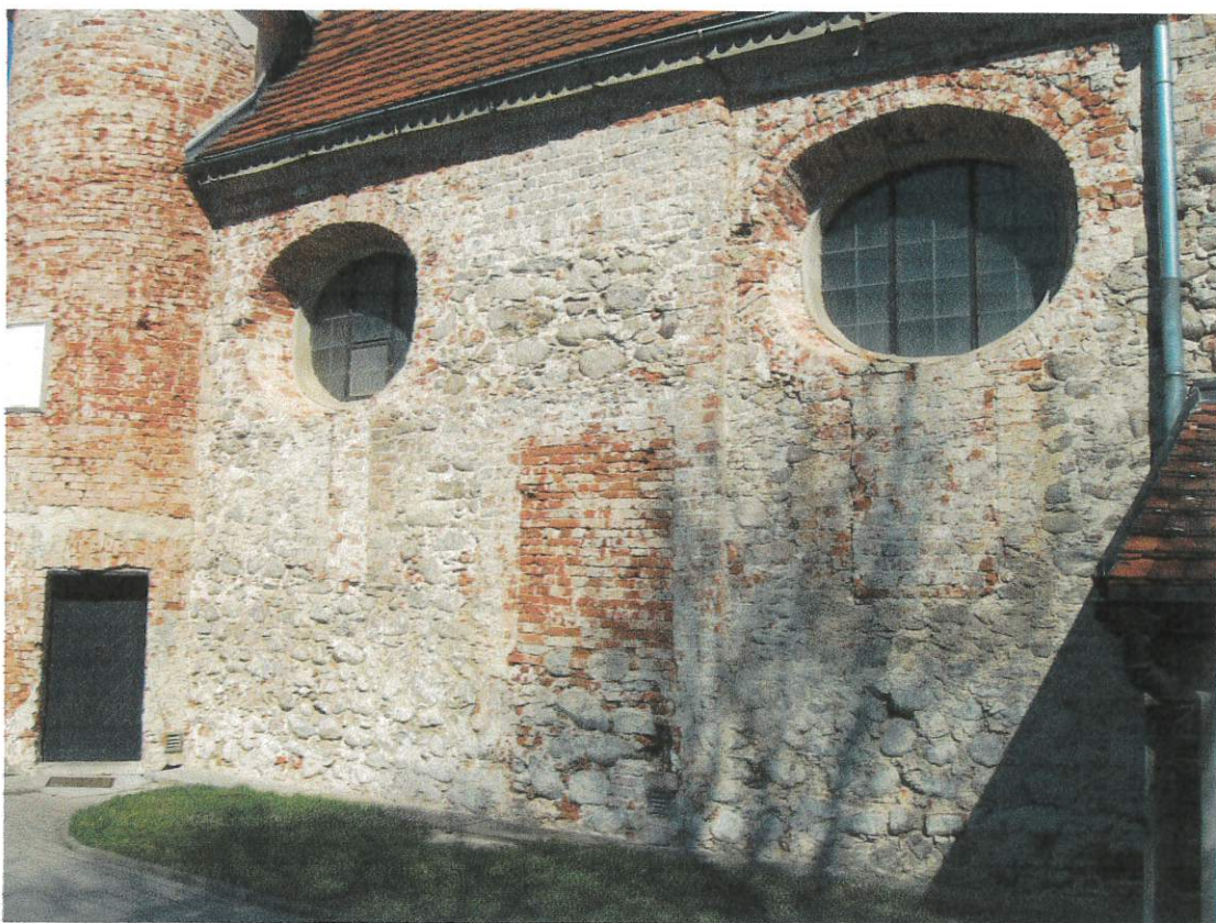
Fot. 2. Fragment elewacji południowej po odkuciu tynku - widok wtórnych zamurowań otworów ;
