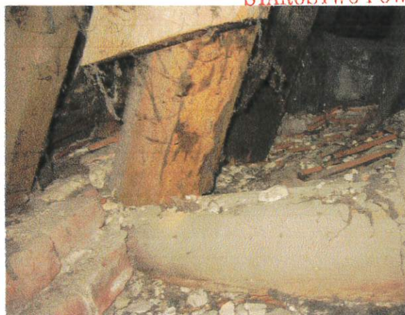
Fot. 13. Widok wtórnych wzmocnień dolnych krokwi w miejscu oparcia na koronie murów ;
